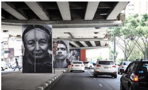
Figura 1: Pilares do viaduto do Minhocão, em São Paulo, com o projeto Giganto, da fotógrafa Raquel Brust.
